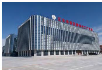
辽东湾新区精细化工产业园项目
