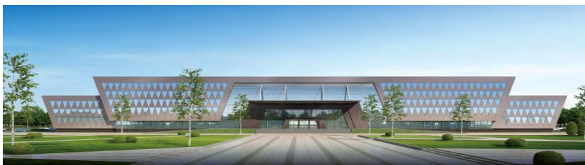
恒力石化（大连）炼化公司 2000 万吨年炼化一体化项目联合运营中心
