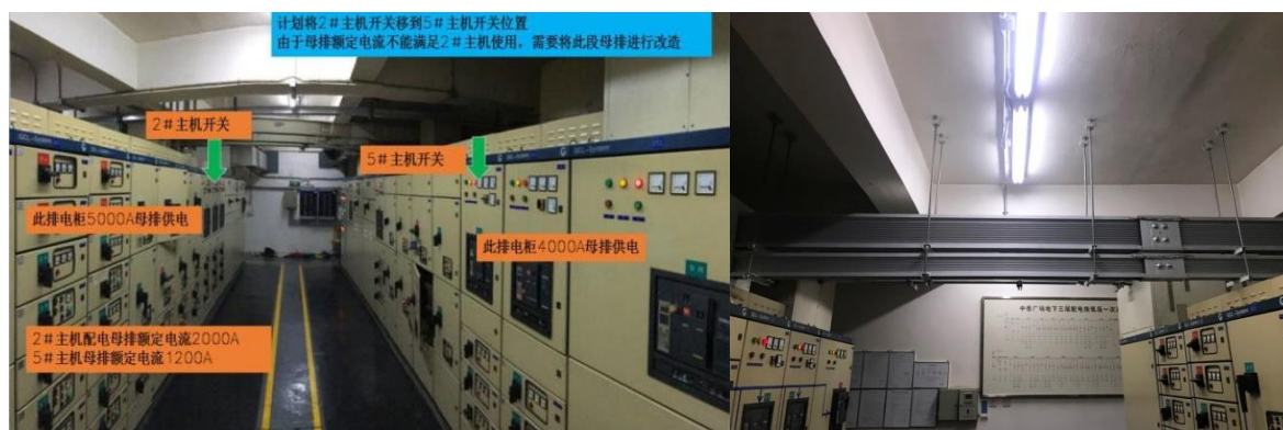
主机配电改造现场照片
