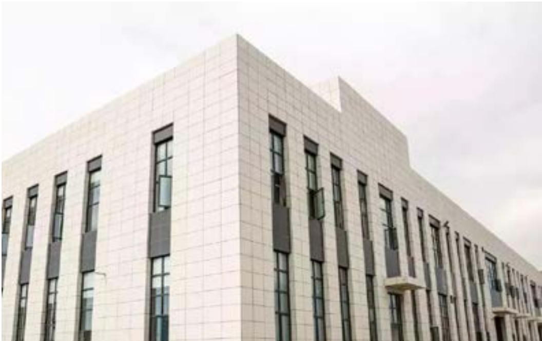
▲东航基地项目一阶段机务维修及特种车辆维修区 采用立邦一体板作为外墙解决方案
