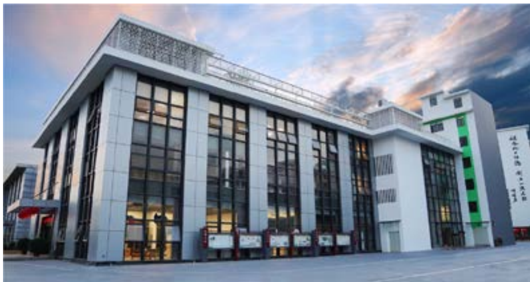
▲ 深圳宝安为明双语学校改造后实景
