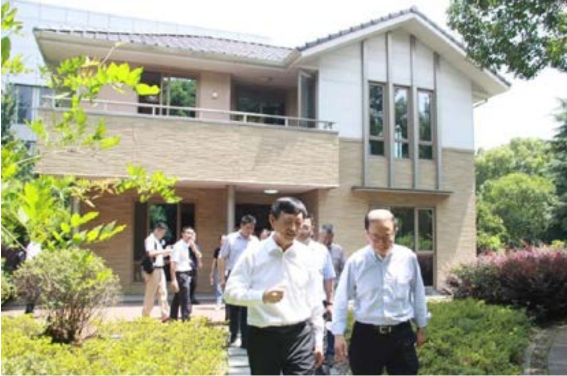
▲ 宝业新农村工业化住宅样板房项目
