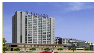
贵州息烽人民医院可再生能源站
