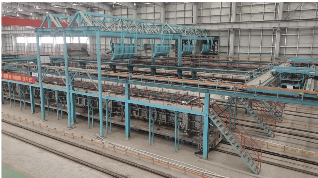
图 8 梁厂流水生产线
