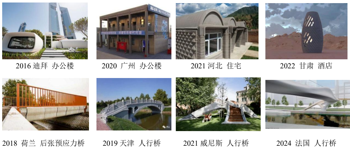
图 1 现有混凝土结构打印建造工程案例
