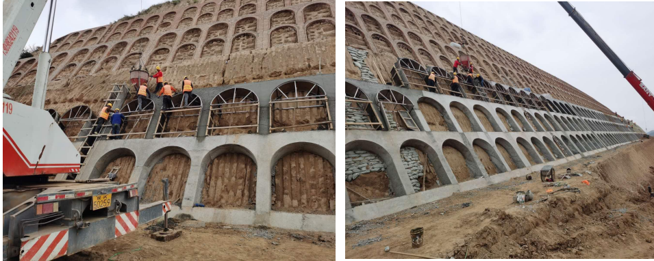
图 C.0.5 路基（K1+703~K8+560）边坡护坡骨架混凝土施工
