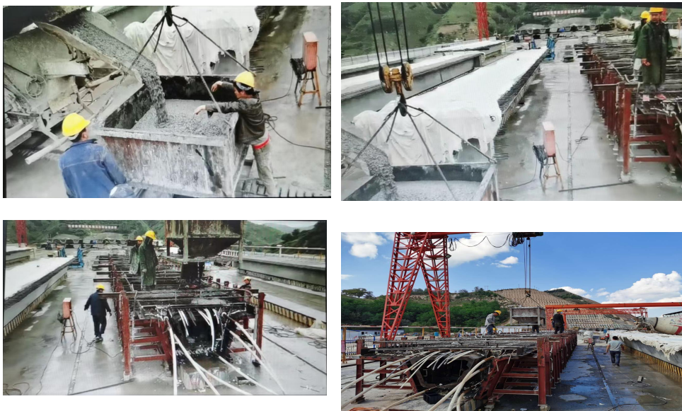
图 C.0.9-1 C50 预制箱梁混凝土施工
