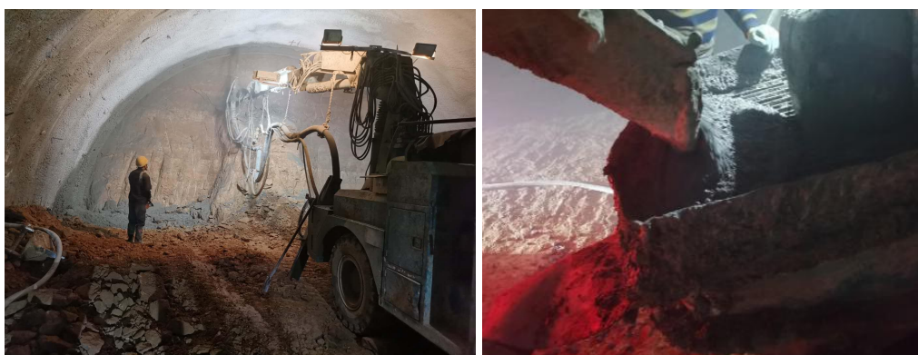
图 C.0.3-3 沙漠砂混凝土喷射作业
