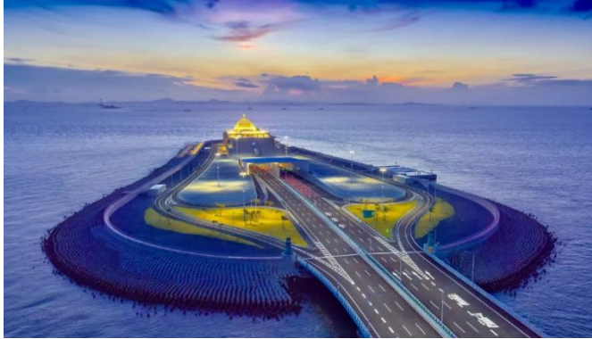
图 13 港珠澳大桥人工岛
