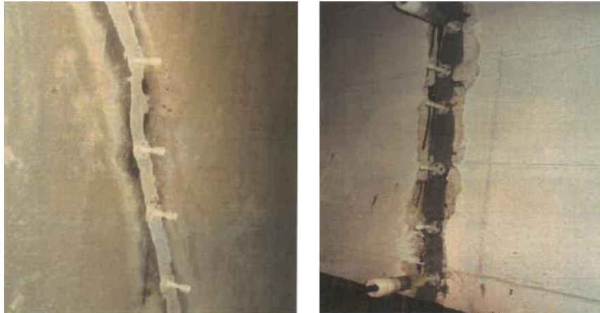
图8 采用压力注浆法修复塔筒裂缝
