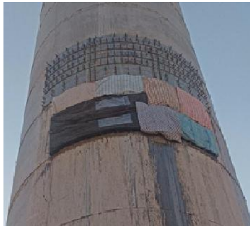
图9 采用粘钢加固法进行混凝土塔筒补强修复
