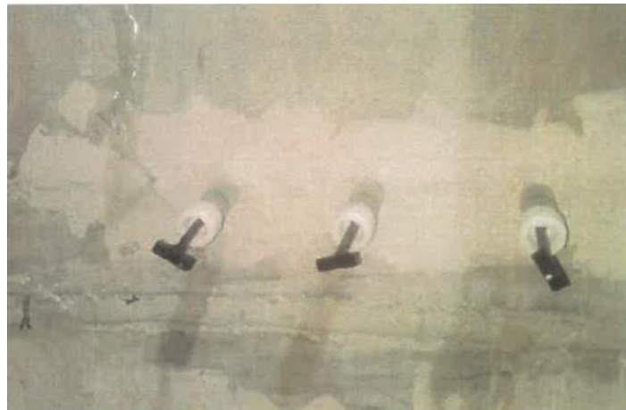
图 7 采用压力注胶法进行塔筒水平缝修复
