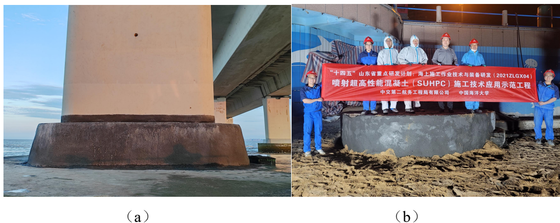
图 3-6 (a) 杭州湾跨海大桥湿接头防护 (b) 青岛栈桥景区建筑物修复
