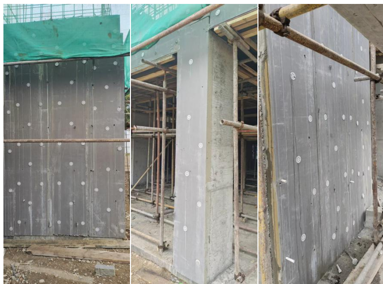
图 2 微硅酯保温板施工现场照片
