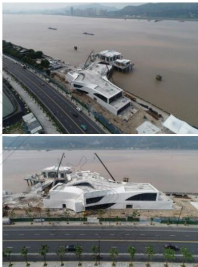
图示 参数化建造与安装现场
