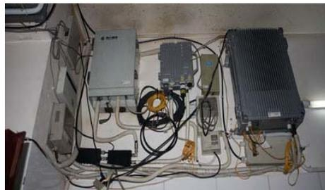
4) 弱电布线网络线最好用超五类线, 电话线也可用网络线, 视频线最好用当地有线电视部门提供的。
