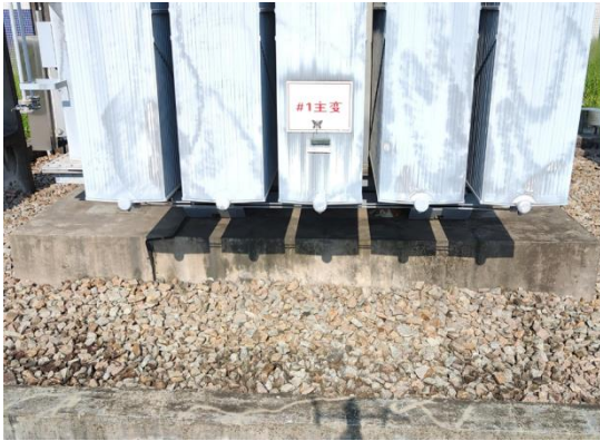
图 E. 1. 1-11 底部漏油拍摄示例
