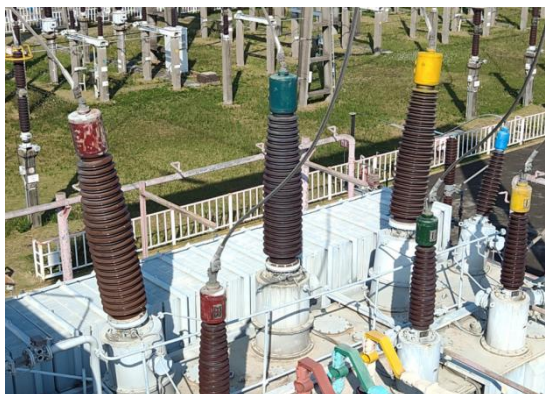
图 E. 1. 1-3 套管外观拍摄示例
