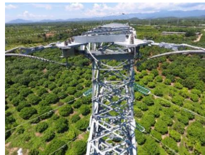
图 C. 3. 1-2 地线耐张线夹
