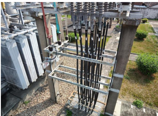
图 E. 1. 1-15 入地电缆拍摄示例
