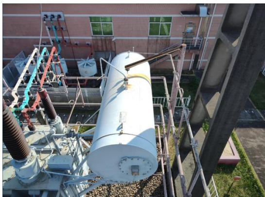
图 E. 1. 1-1 油枕外观、法兰、螺丝拍摄示例
