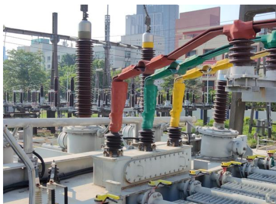
图 E. 1. 1-5 低压套管升高座拍摄示例
