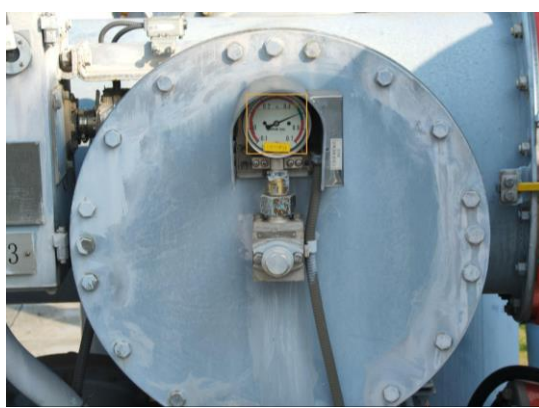
图 E. 2. 2-2 SF6 压力表拍摄示例
