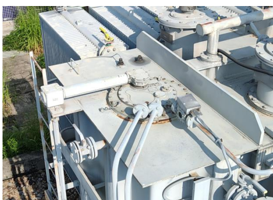
图 E. 1. 1-7 主变顶部法兰（细节）拍摄示例
