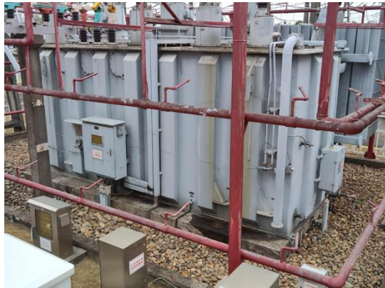
图 E. 1. 1-18 主变各侧全景拍摄示例
