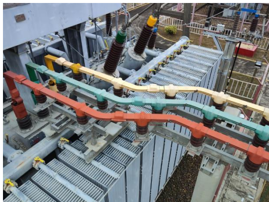
图 E. 1. 1-14 母线桥拍摄示例
