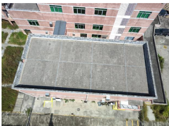
图 E. 2. 3-5 建筑物楼顶拍摄示例
