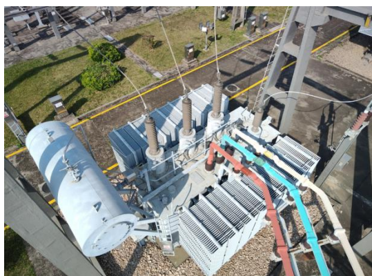
图 E. 1. 1-6 主变顶部外观（全景） 拍摄示例
