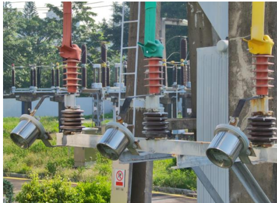
图 E. 1. 1-16 低压侧避雷器拍摄示例
