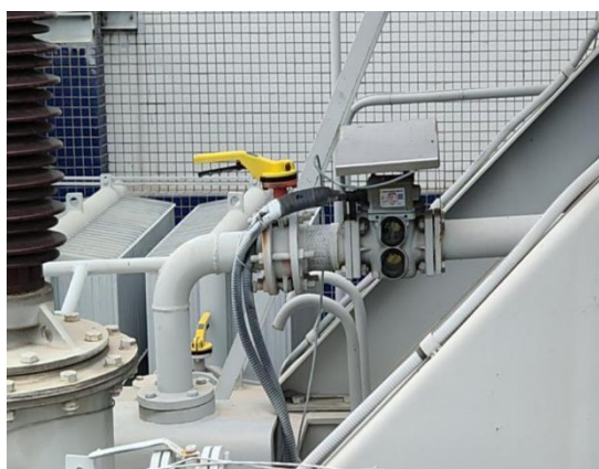
图 E. 1. 1-9 瓦斯继电器（外观）、把手型阀门 拍摄示例
