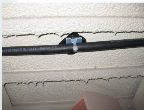
单组份PU胶粘接固定线的夹子
