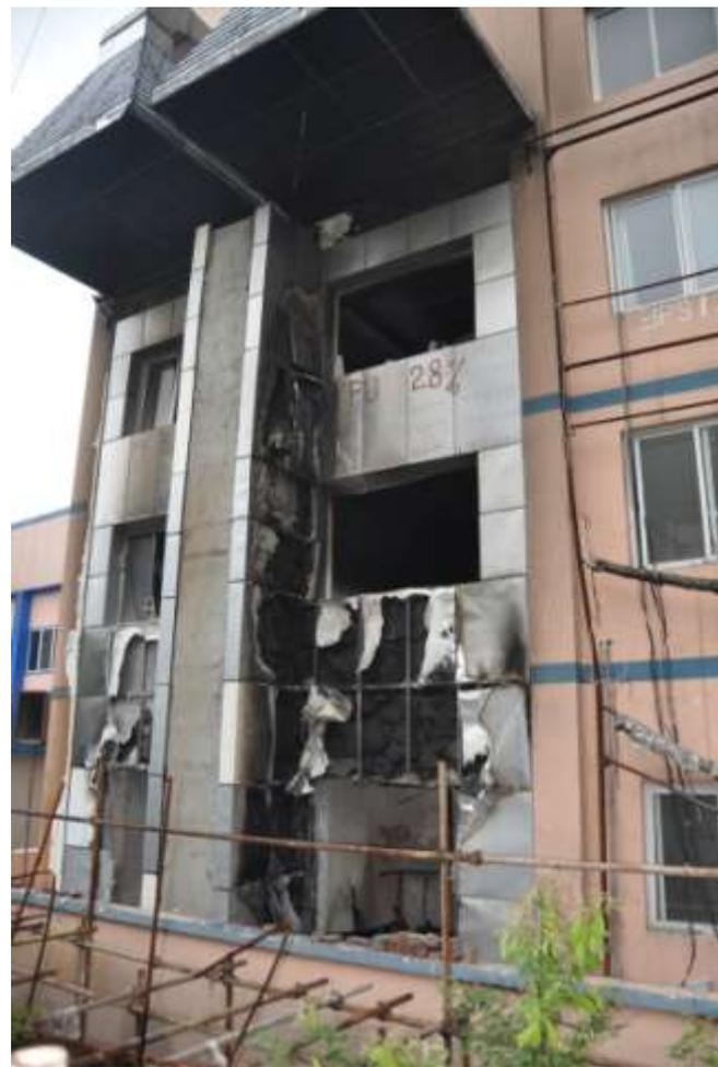
幕墙-PU80MM30% (隔离带) D级泡沫, B级铝塑板
