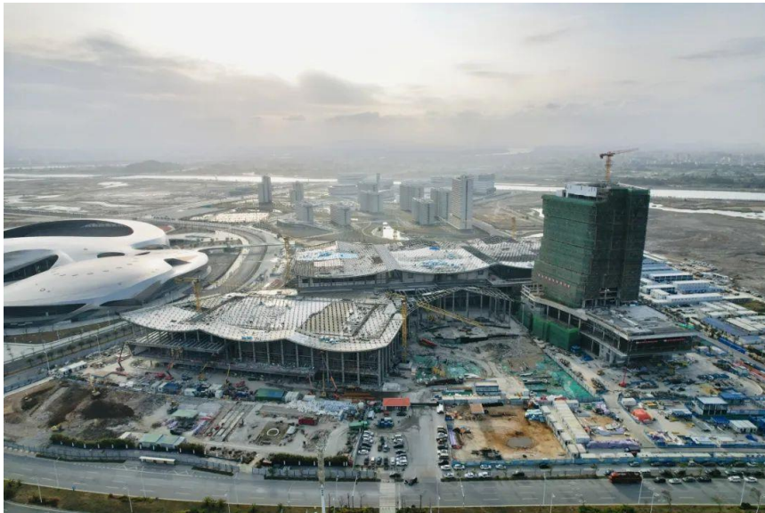
汕头国际会展中心施工现场
