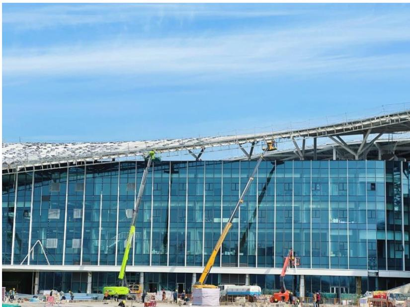
“目前，我们正在加紧建设当中，各场馆主体结构、二次结构已全部完成，屋面、花冠钢结构主体已基本完工，各单体正在进行室内装饰装修。”河北建工集团园博会主展馆项目经理孙晓伟介绍。
