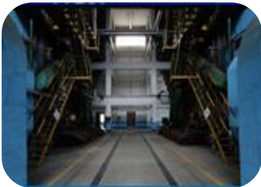
供热站改造前
