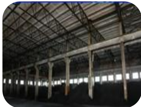
煤库内部改造前
