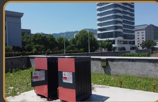
台州宁溪镇 乡村微管网示范项目
