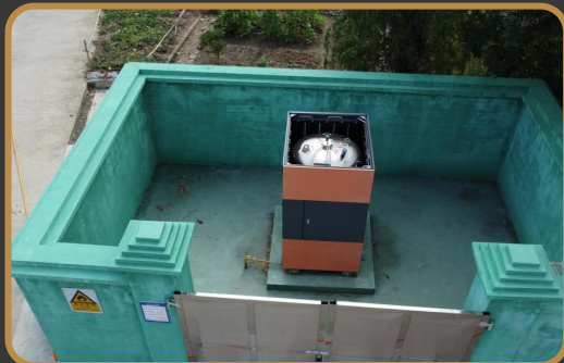
淳安县下姜乍尔村 乡村微管网示范项目
