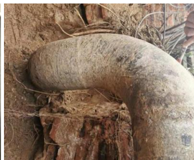
管道特征复杂 (高焊缝、连续弯头、斜接弯头)
