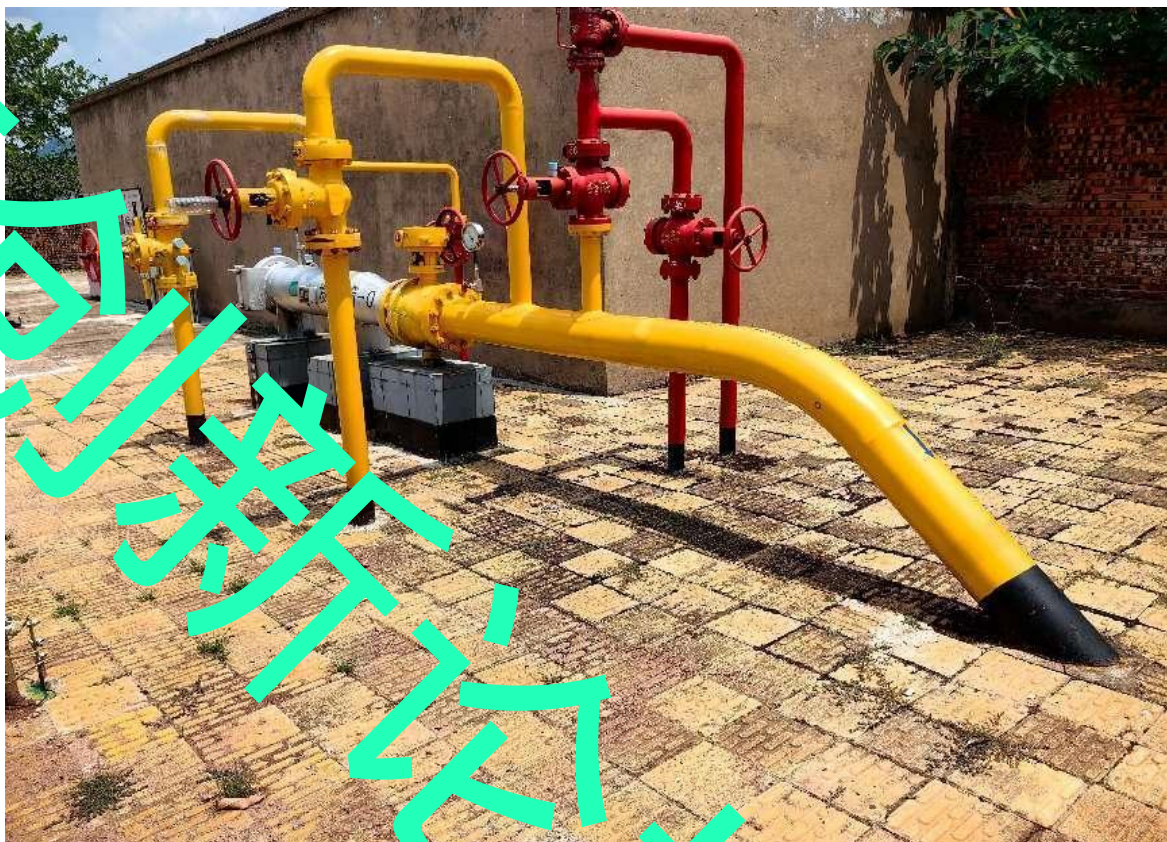
收发球筒大筒长度过短，且非标称直管段
