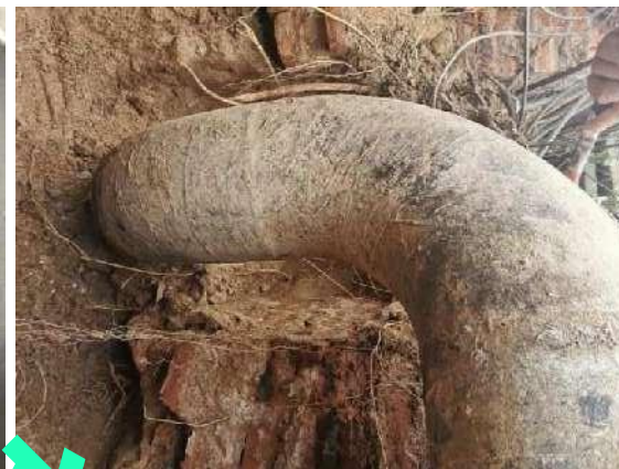
管道特征复杂 (高焊缝、连续弯头、斜接弯头)
