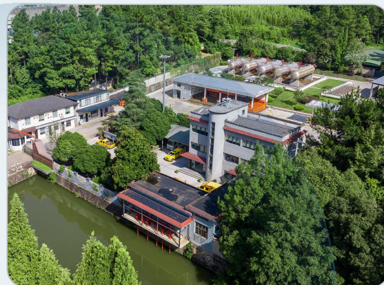
液化石油气储配站
