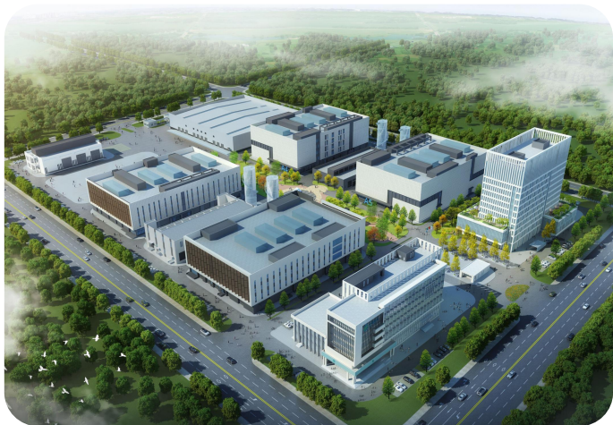
中国移动青岛数据中心余热利用项目
