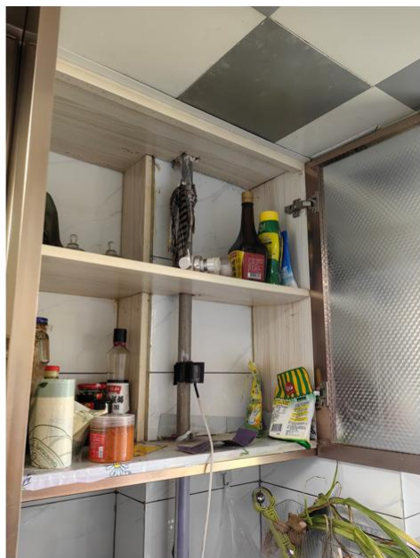
图像为向上检测301与401穿楼板位置，楼顶距探头570mm左右，570mm以上716mm左右有反馈信号。
