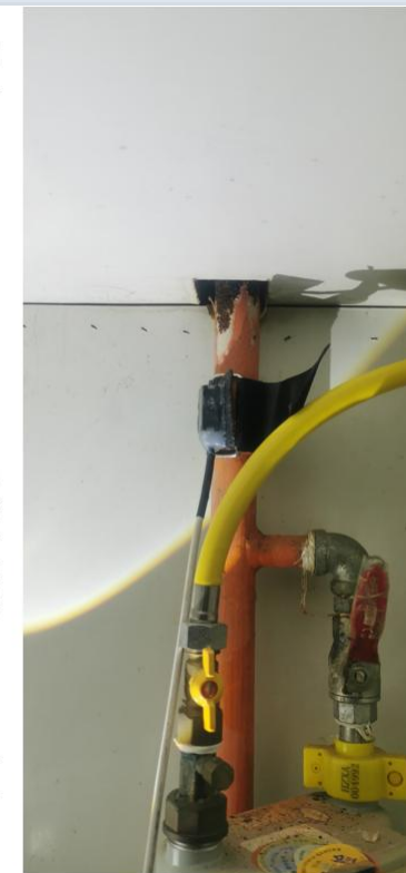
图像为向下检测三通位置，距探头95mm左右。
