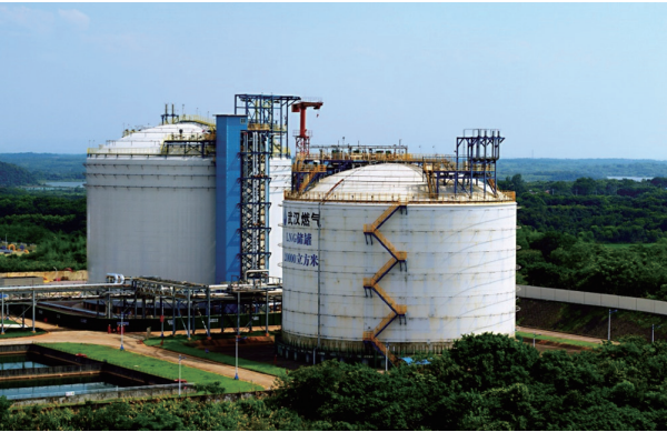
安山LNG储存基地
