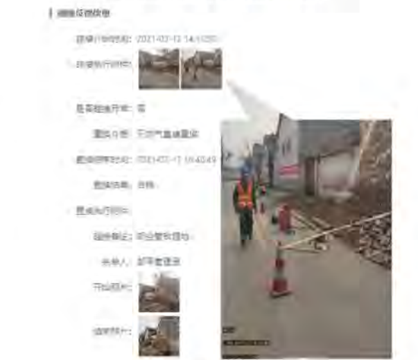
图14系统内某带气作业现场反馈照片2
