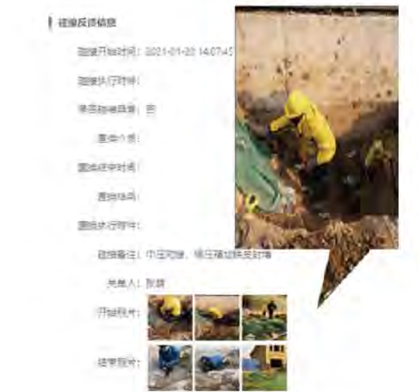
图13系统内某带气作业现场反馈照片1
