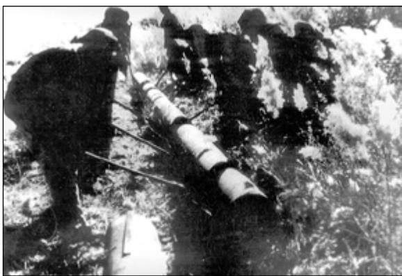
建设者正在铺设新中国第一条原油长输管道——克拉玛依至独山子管道。
