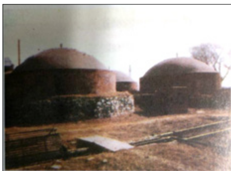
门头沟油库土油罐板库（摄于 1971 年）
