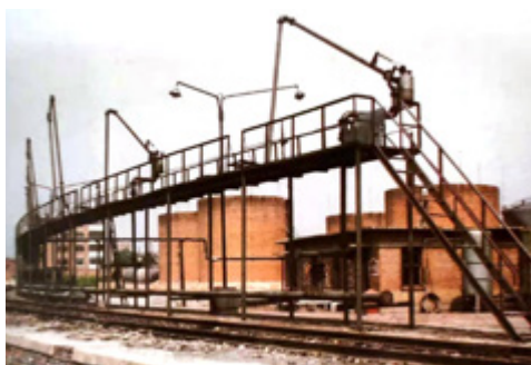
沧州公司油库油罐区砖墙 包围等防护伪装处理
