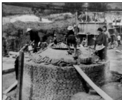
土油罐建设工地（摄于 1971 年）
