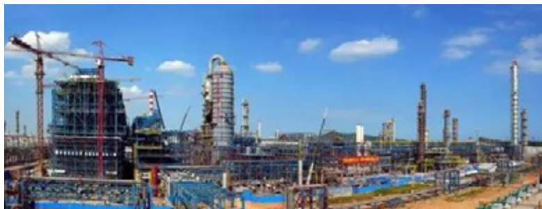
浙江石化 4000 万吨 / 年炼化一体化炼油项目
