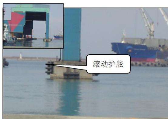
图 4.1 韩国浦项制铁船库码头护舷布置图
